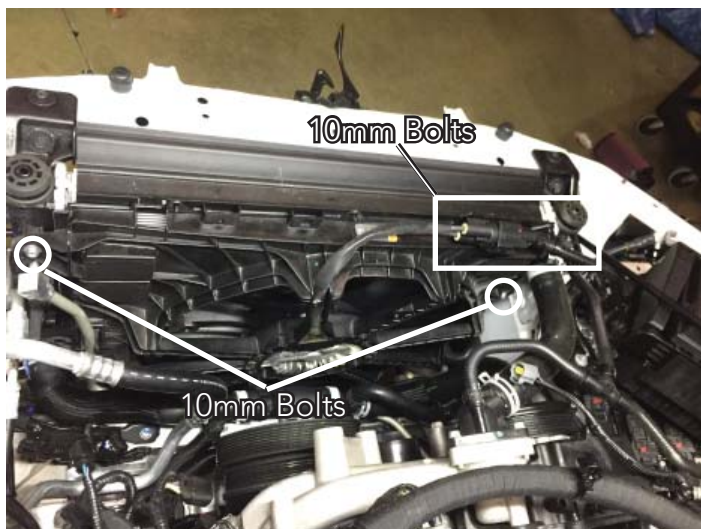
Fan Electrical Connector / Bolts
